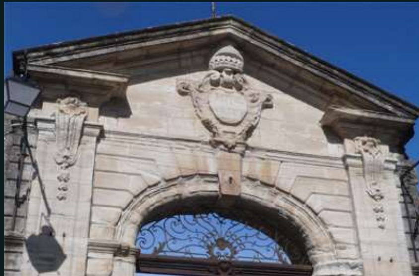
grès du Trias : pierre de construction (Lodève)
